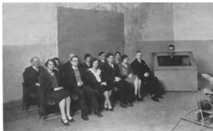
Figura 2: Sistema de medição do coeficiente de absorção de audiência realizado no National Bureau for Standards-NBS, EUA em 1929(CHRISLER, (1935)
