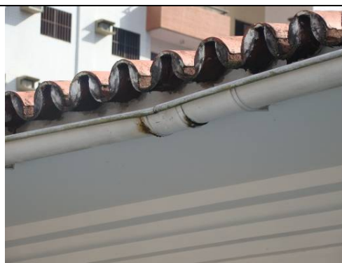
Calha do prédio principal
